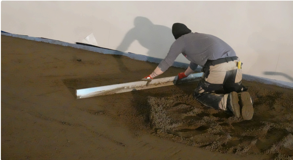
Der Randstreifen steht an allen Wänden, bevor der Estrich eingebracht und abgezogen wird.
