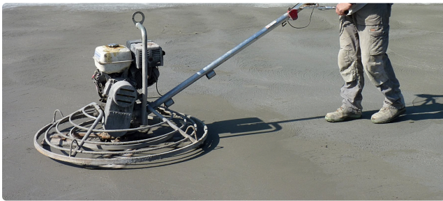
Abglätten der frischen Oberfläche mit dem Flügelglätter.
